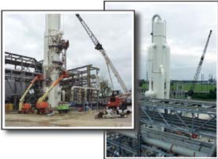
2200 ton Jet-Vac® vacuum chiller
